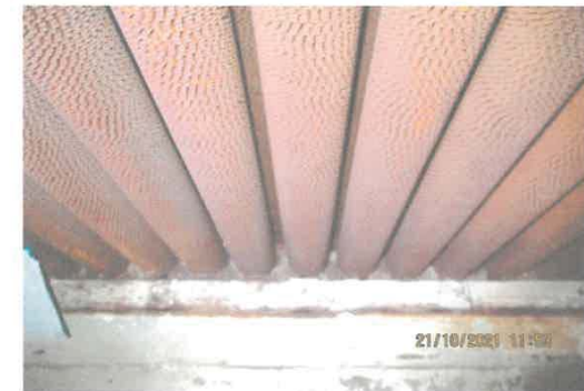
ตรวจสอบสภาพท่อน้ำภายในหม้อไอน้ำ ด้าน Low Pressure หม้อไอน้ำหมายเลข 6( HRSG-05 ) บริษัทสหโคเจน (ชลบุรี) จำกัด(มหาชน) วันที่ 23 ตุลาคม 2565
