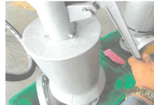
ตรวจสอบSafety Valve ต่างๆทำงานตามค่าที่กำหนด หม้อไอน้ำหมายเลข 6( HRSG-05 ) บริษัทสหโคเจน (ชลบุรี) จำกัด(มหาชน) วันที่ 23 ตุลาคม 2565
