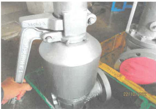
ตรวจสอบSafety Valve ต่างๆทำงานตามค่าที่กำหนด หม้อไอน้ำหมายเลข 6( HRSG-05 ) บริษัทสหโคเจน (ชลบุรี) จำกัด(มหาชน) วันที่ 23 ตุลาคม 2565
